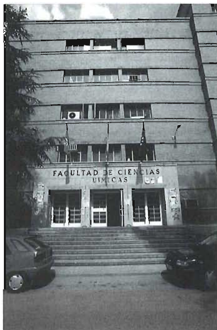
Università Complutense di Madrid: la facciata della facoltà di Chimica
