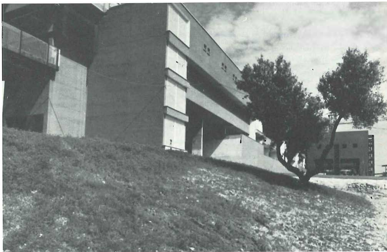
Università della Calabria: il fabbricato ponte
