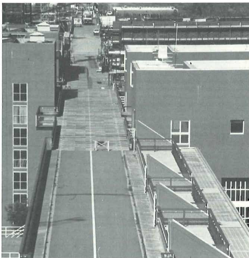
Università della Calabria: veduta aerea dell'asse attrezzato
