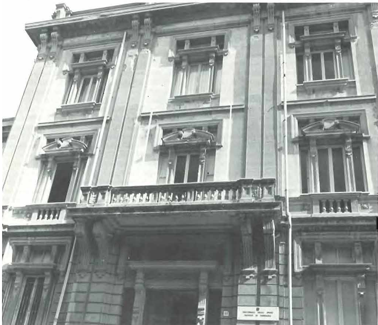
Università di Sassari: la facciata dell'Istituto di Tecnica farmaceutica
